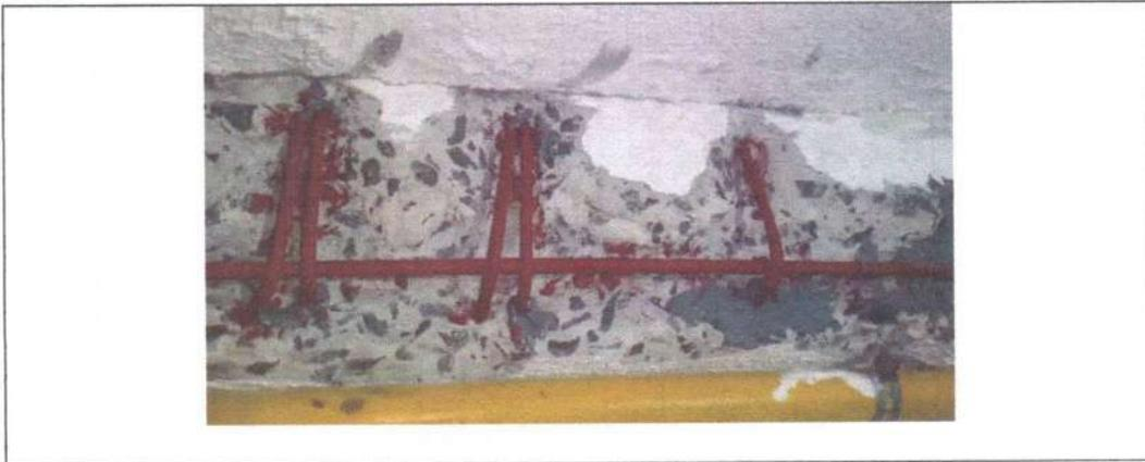
Cabe ressaltar que, a fixação do aço na estrutura consiste na execução de furo da estrutura existente com utilização de martelete, injeção de argamassa epoxídica e o aço, atividade que apresenta complexidade executiva maior que a fixação do aço em solo maciço.
